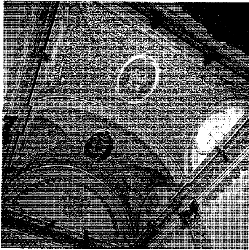
Monasterio de Veruela. Sacristía. Detalle del sistema de abovedamiento.
