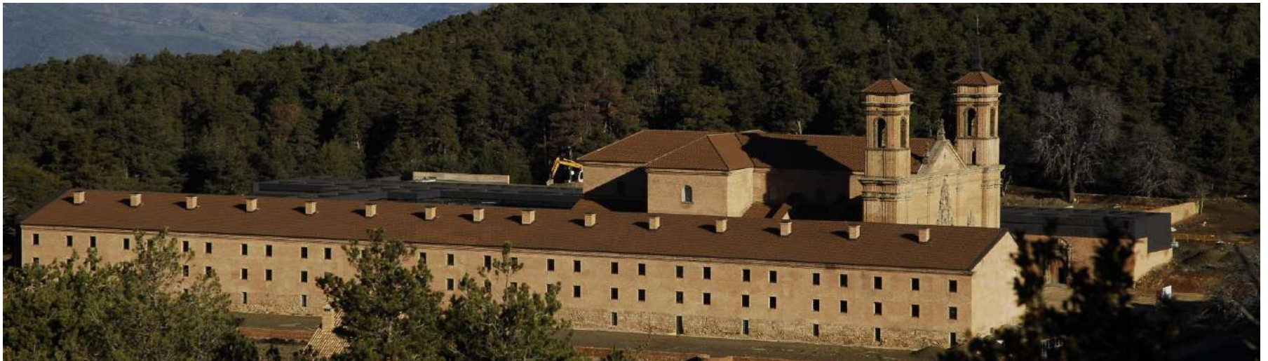
El monasterio nuevo de San Juan de la Peña en 2007 después de la reahabilitación
